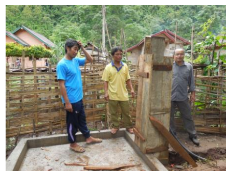
Fontaine en construction
