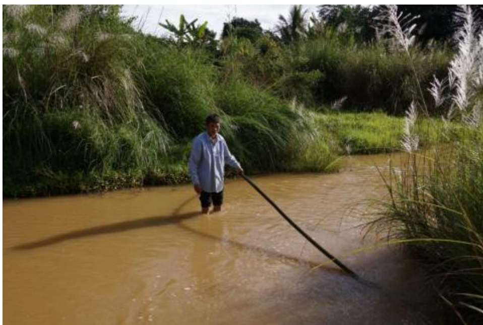
Le tuyau d'eau à faire passer en aérien
