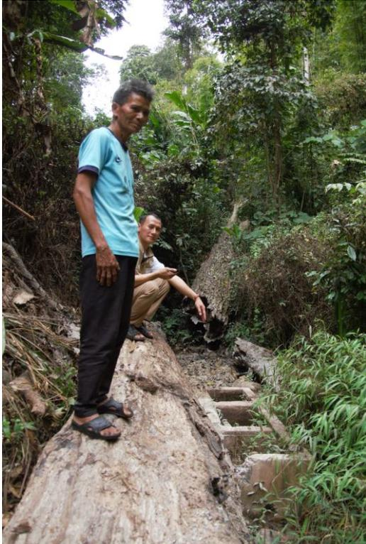
Destruction du captage par la chute d'un arbre
